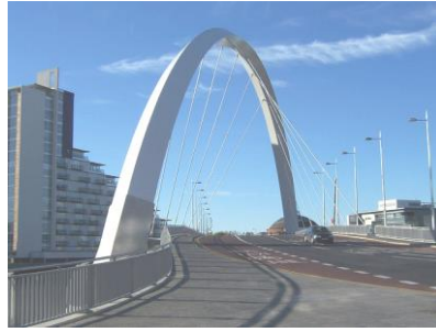
Рис. 4. Мост Hulme Arch Bridge. Великобритания
